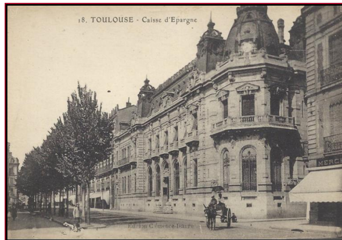
Bâtiment de la Caisse d'Épargne, Toulouse
